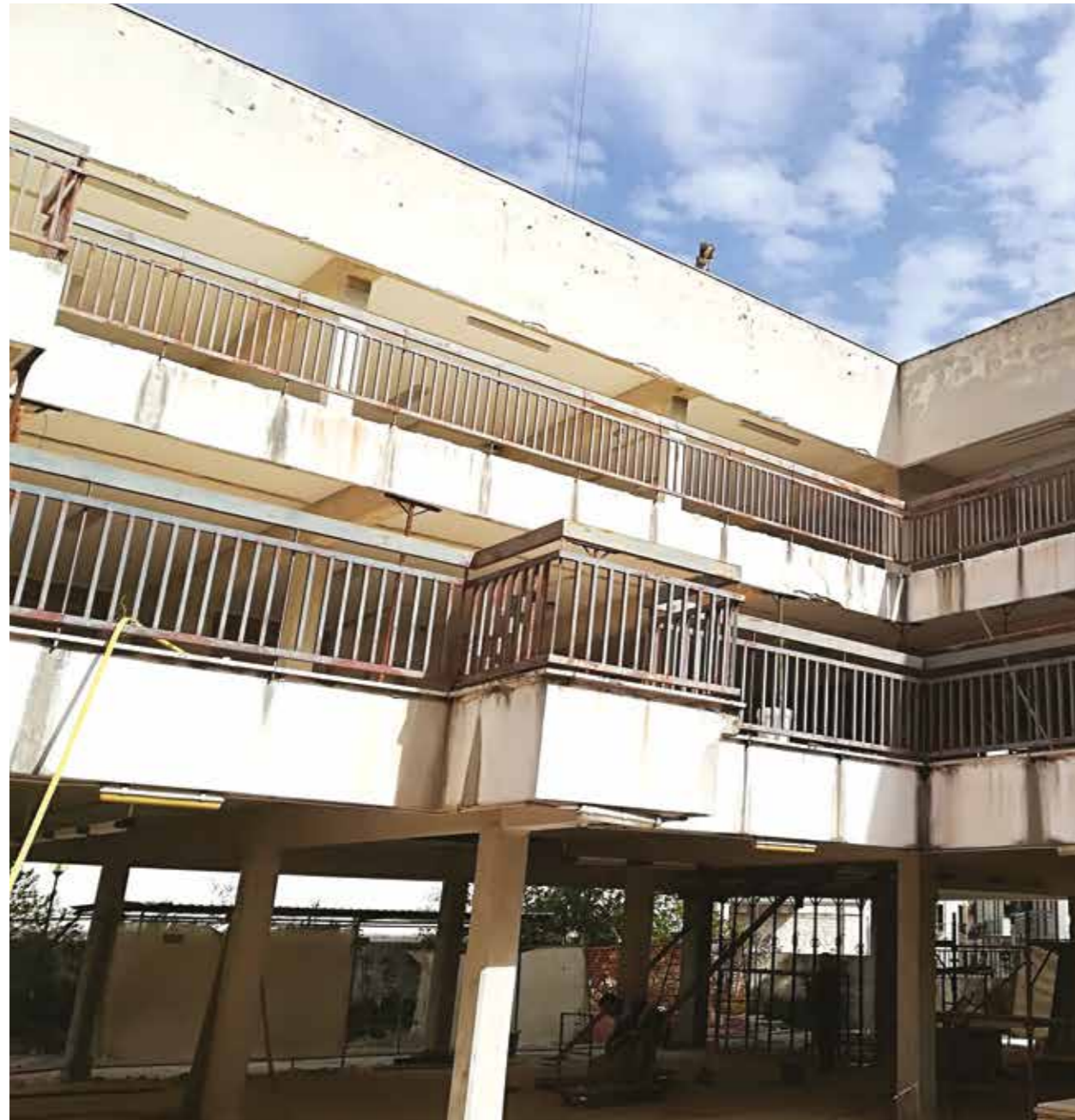
R.S.A. seismic retrofit Municipality of Giovinazzo (BA)
